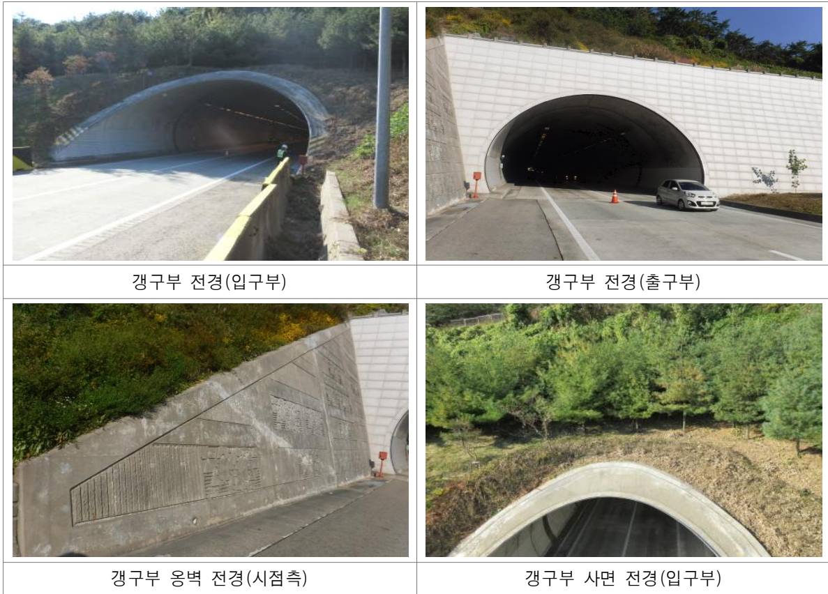
〈사진 3.8〉 갱구부 및 옹벽, 사면 전경
