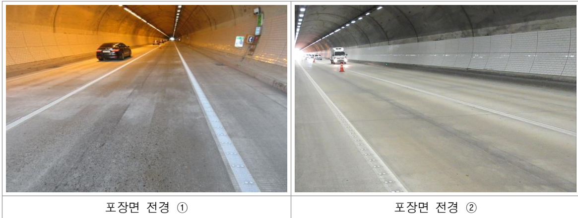
〈사진 3.6〉 터널 포장면 전경
